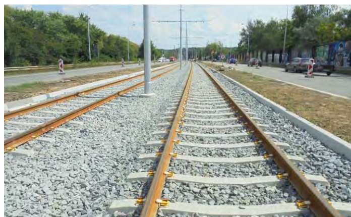
Na stavbě bylo použito 4700 betonových pražců a 1700 dřevěných pražců
