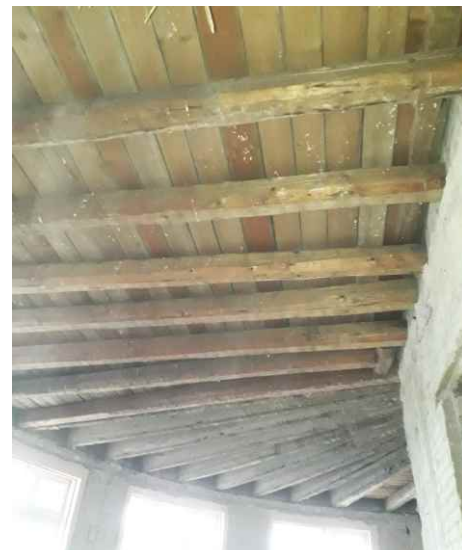
Odhalené stropy ukázaly skutečný stav dřevěných trámů
