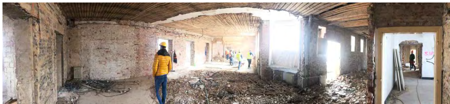
Panoramatický snímek stavu 5. nadzemního podlaží (4. patra), kde již jsou vybourány příčky a odstraněná omítka ze zdí a stropů
